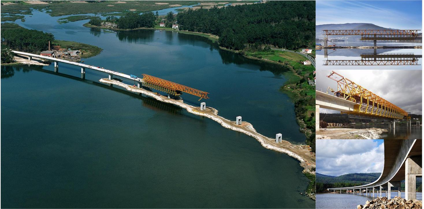
El viaducto sobre la Ensenada de Engano forma parte del proyecto de mejora del trazado de la carretera C-550 entre las localidades de Cee y Tui. Se trata de un viaducto de 721 m de longitud repartidos en vanos de luces 41.00 + 9 x 70.00 + 50.00 m.
